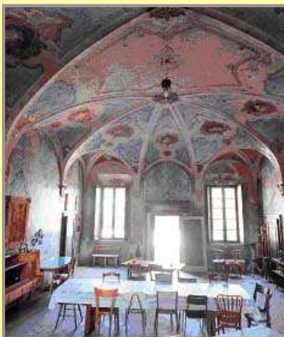
La volta ad ombrello di una delle stanze del Castello
