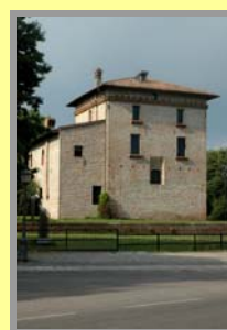
La Torre nella frazione di Boldeniga
